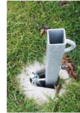
Der Halter für Leitpfostensockel mit Arretierung wird einfach nur in den Leitpfostensockel hineingesteckt. Durch die verschiebbare Arretierung sichert der Halter sich in dem Sockel. Das Stand-/Schaftrohr oder andere Aufstellvorrichtungen, einfach in die Aufnahme eingesteckt und mit einer Flügelschraube gesichert.
