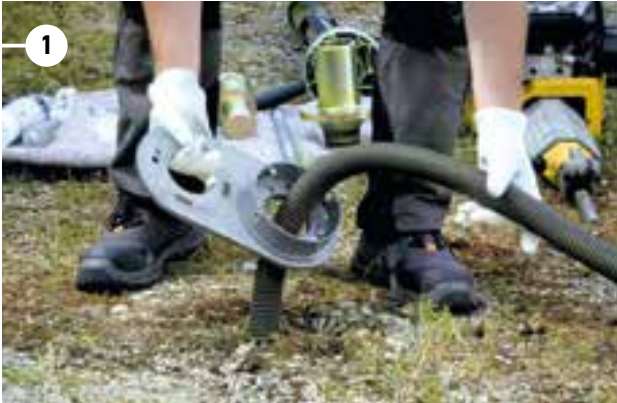
1. Mit Bodenplatte gewünschten Standort festlegen.
