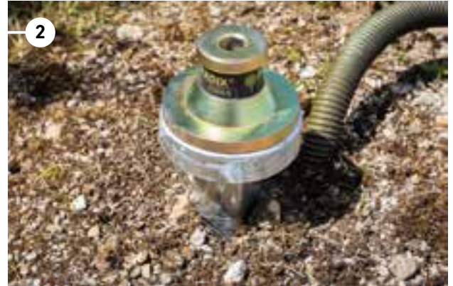
2. Ferradix neben dem Stromkabel eintreiben – Auf Kabel achten!
