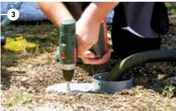
3. Kabel durch Bodenplatte führen und Bodenplatte daneben auf Ferradix festschrauben
