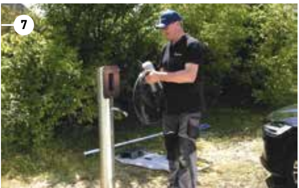
7. Wallbox anschließen – fertig!
