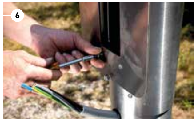
6. Kopfteil mit Universal-Adapterplatte anschrauben. Funktioniert mit allen Wallboxen.
