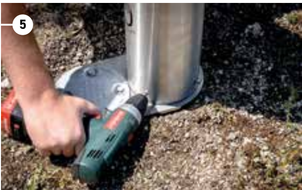
5. Säule festschrauben (Sicherheitsschrauben)
