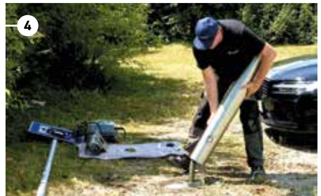
4. Edelstahlsäule aufsetzen (Kabel innenliegend)
